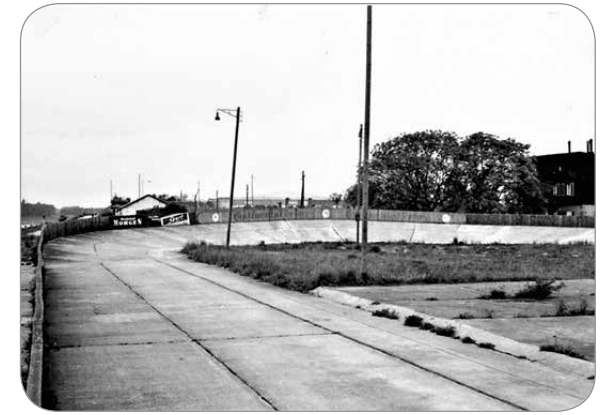
Betonpiste der Radrennbahn Feudenheim
