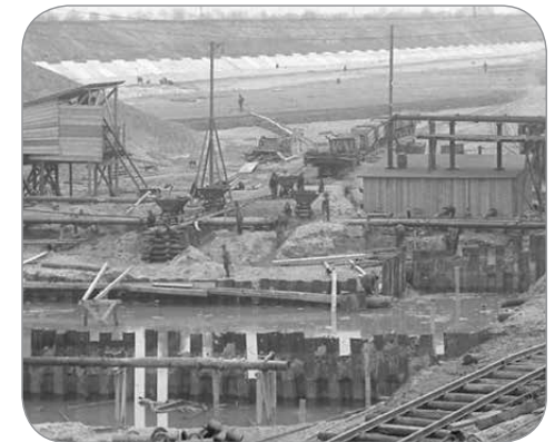
Bau des Kraftwerks Feudenheim
