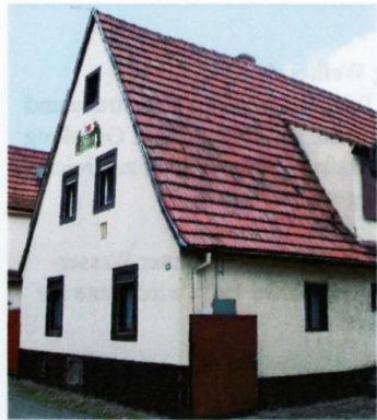
● Vereinshaus in der Eintrachtstraße 26 (Ende des Umbaus 2017)
