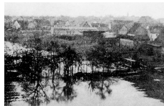
Abb. 5 Der Neckar hat kurzzeitig wieder seinen alten Lauf eingenommen
