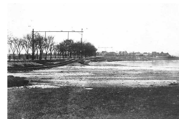
Abb. 7 Die Folgen der Überschwemmung
