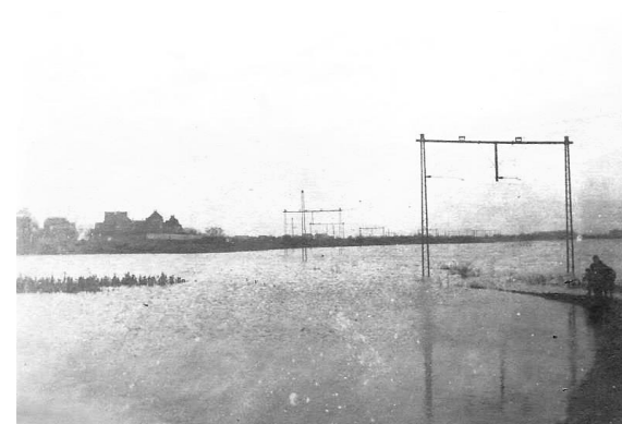
Abb. 6 Blick von Westen auf die überschwemmte Straßenbahnlinie
