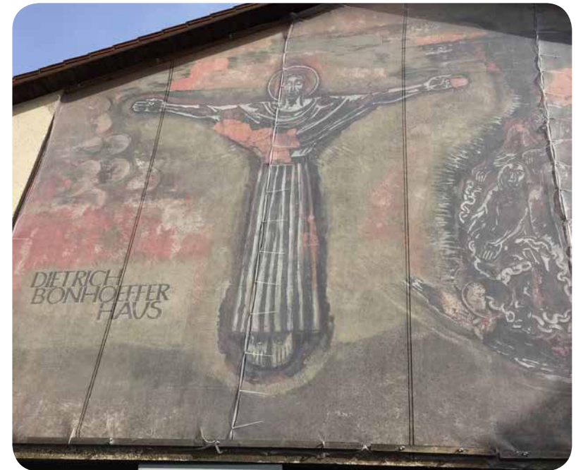
Sgraffitto am Westgiebel des Bonhoeffer-Gemeindehauses (jetziger Zustand)
